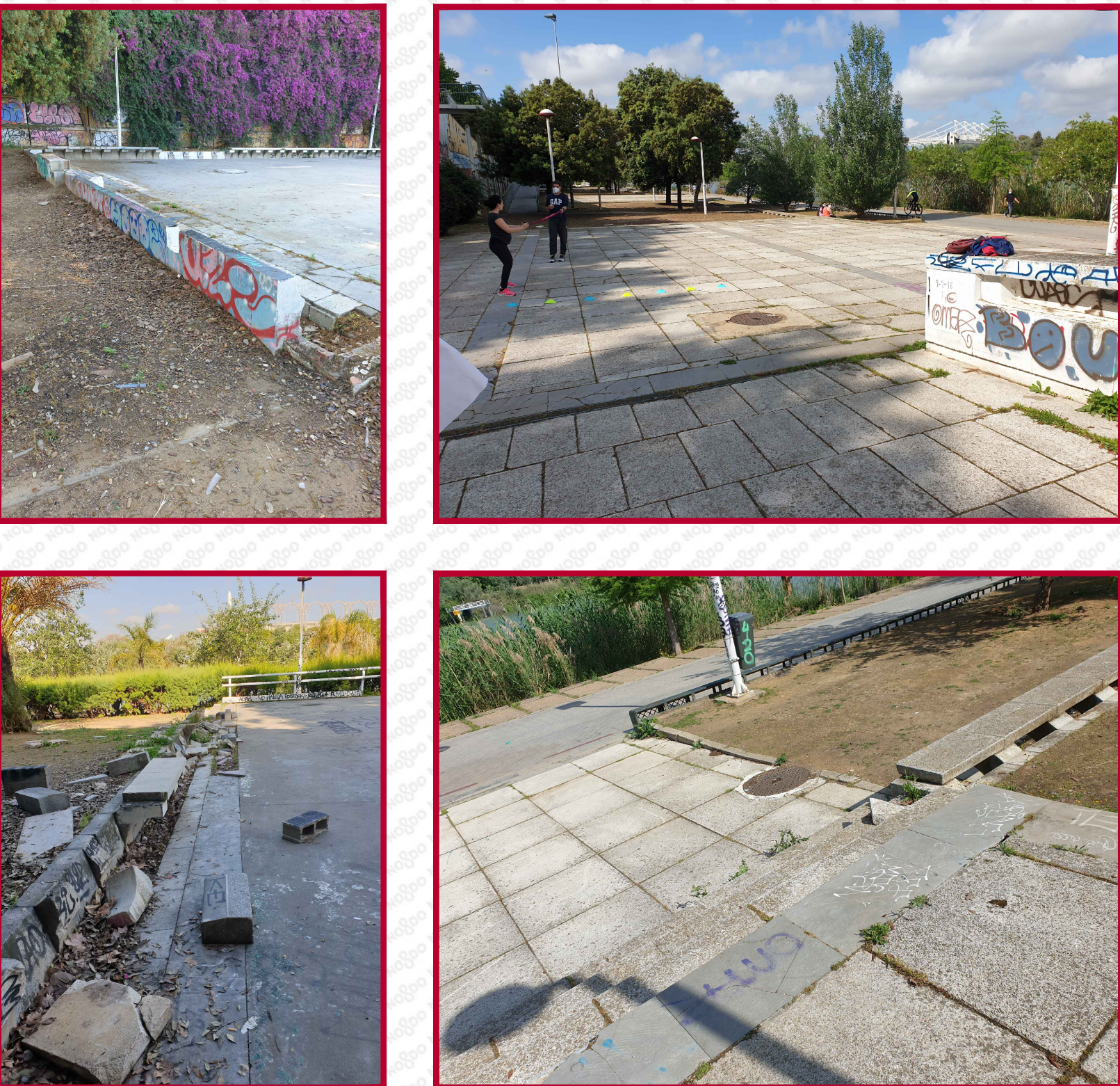
FOTOGRAFÍAS DEL ESTADO ACTUAL
