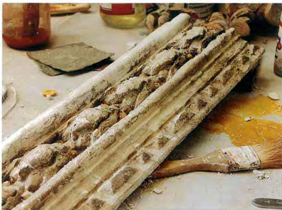
Limpieza de elementos de escayola.
