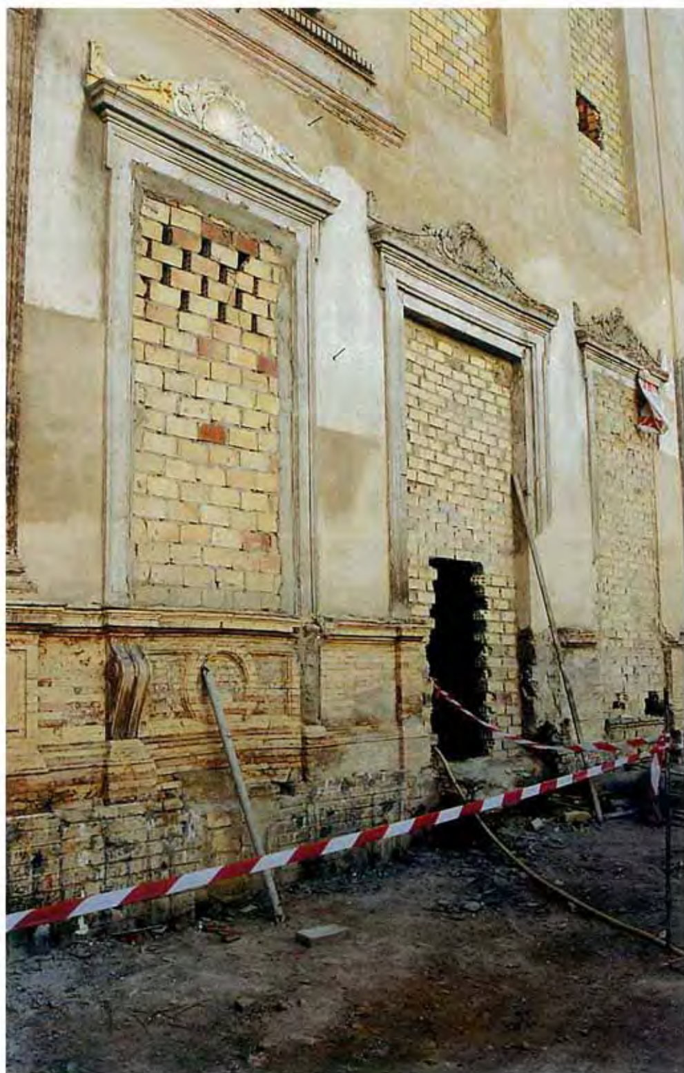
Elementos decorativos de yeso y terracota en ventanas. Zócalo de ladrillo aplastillado.
