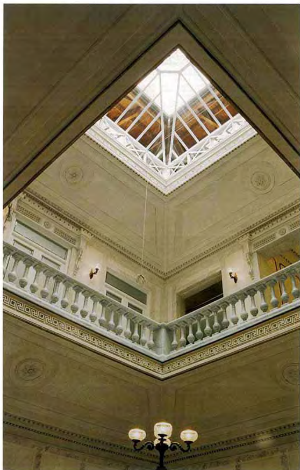
Galerías en torno al patio.
