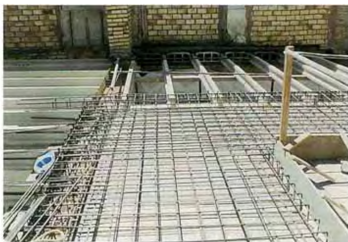
Forjado unidireccional y losa armada,
