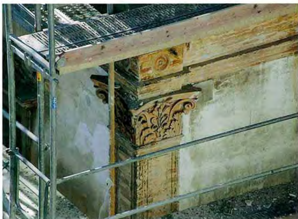
Detalle terracota y ladrillo aplastado.
