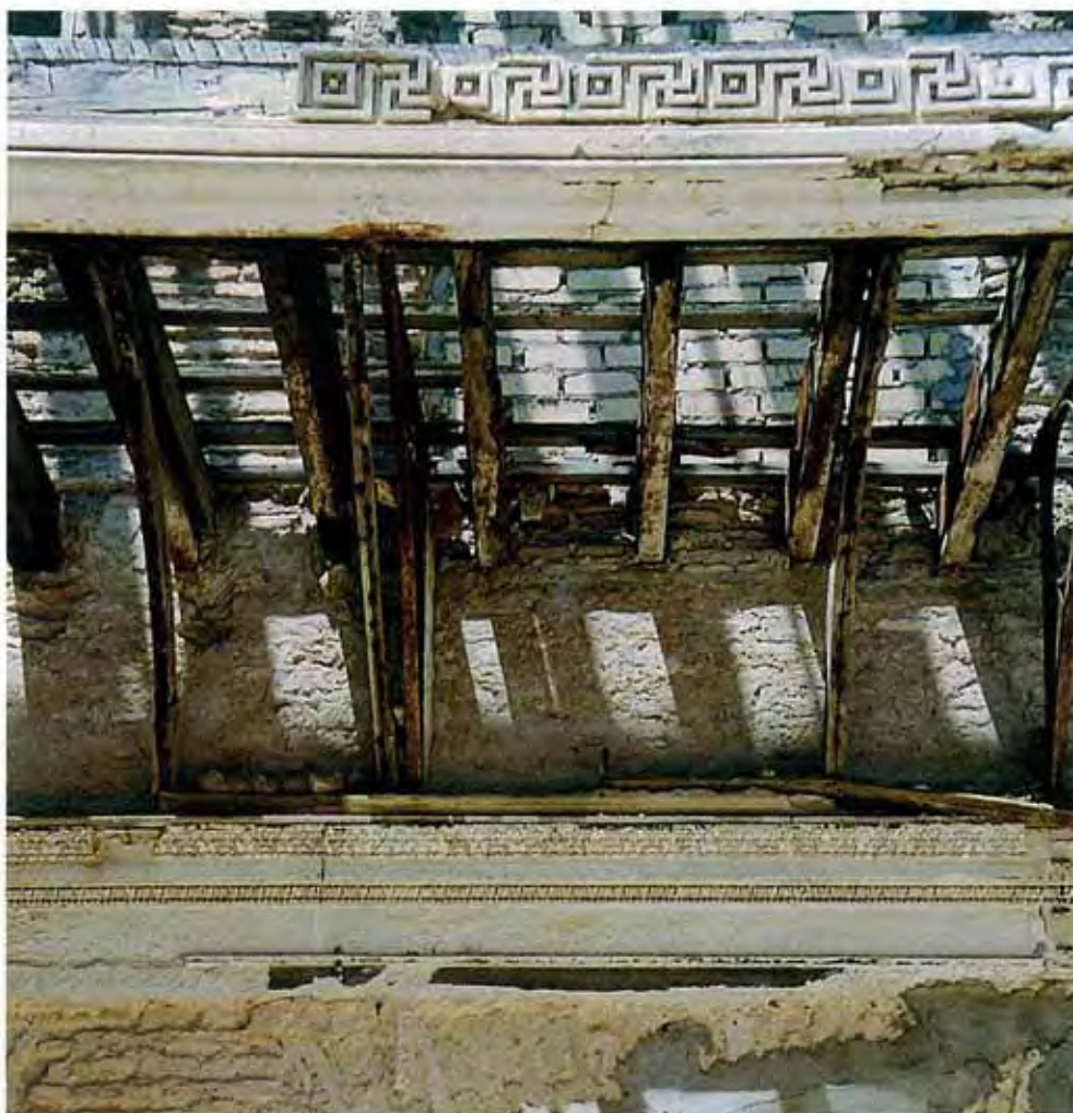
Detalle restos de molduras de escayola y jabalones.
