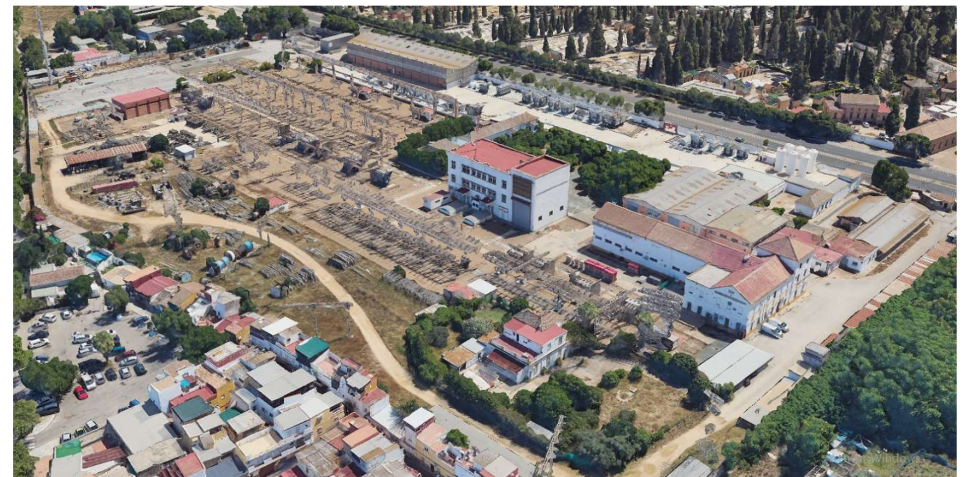
Vista aérea de la Subestación
