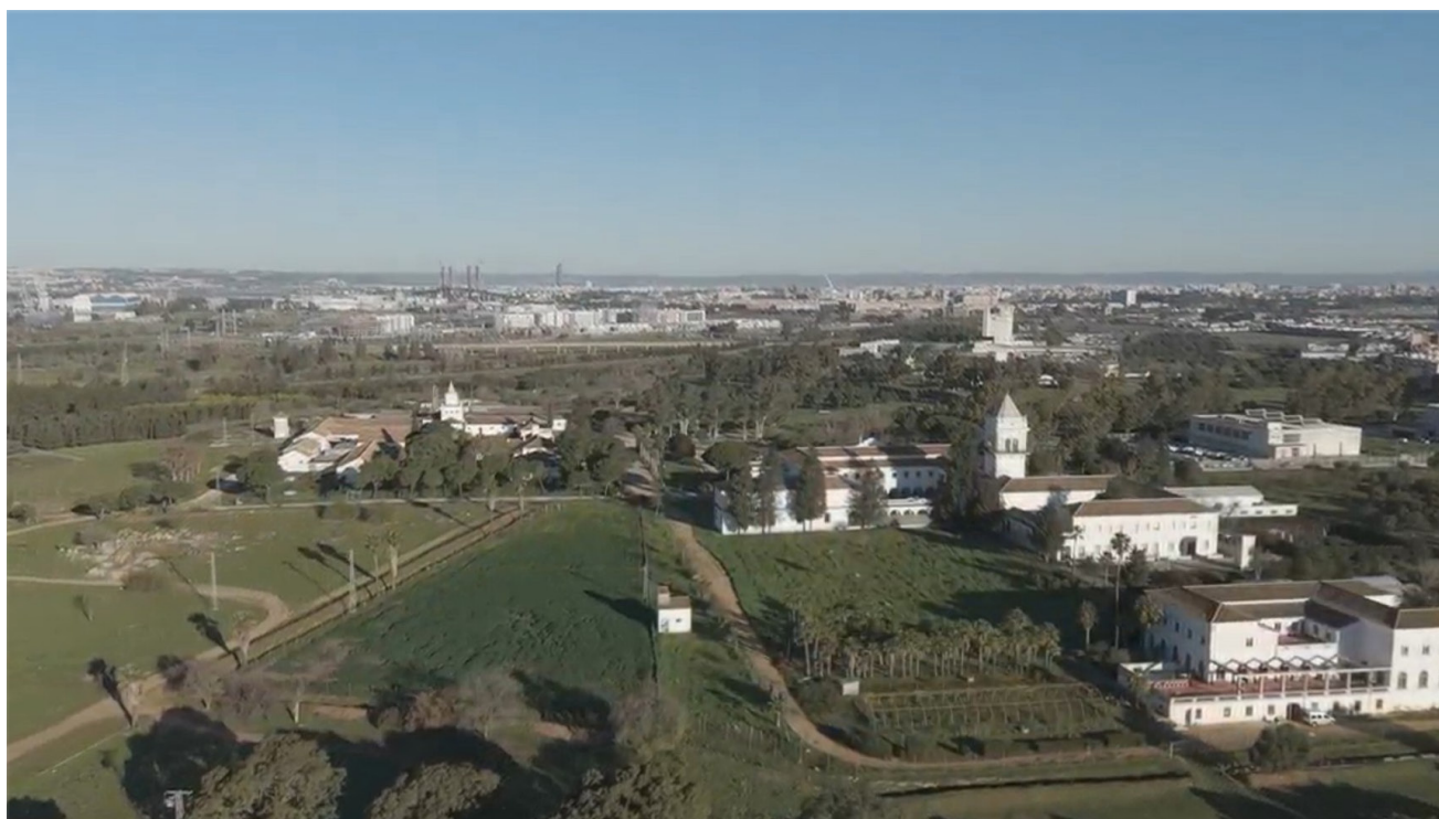
Imagen aérea actual del ámbito P.E. "Cortijo de Cuarto"
