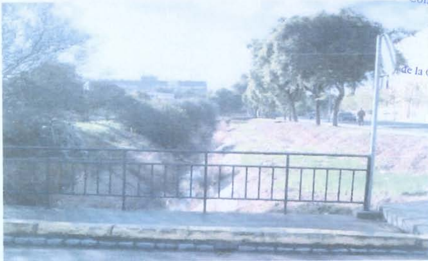
ENCAUZAMIENTO CANAL ARROYO MIRAFLORES Y ACCESO AL POLIGONO POR (C/SECOYA)
