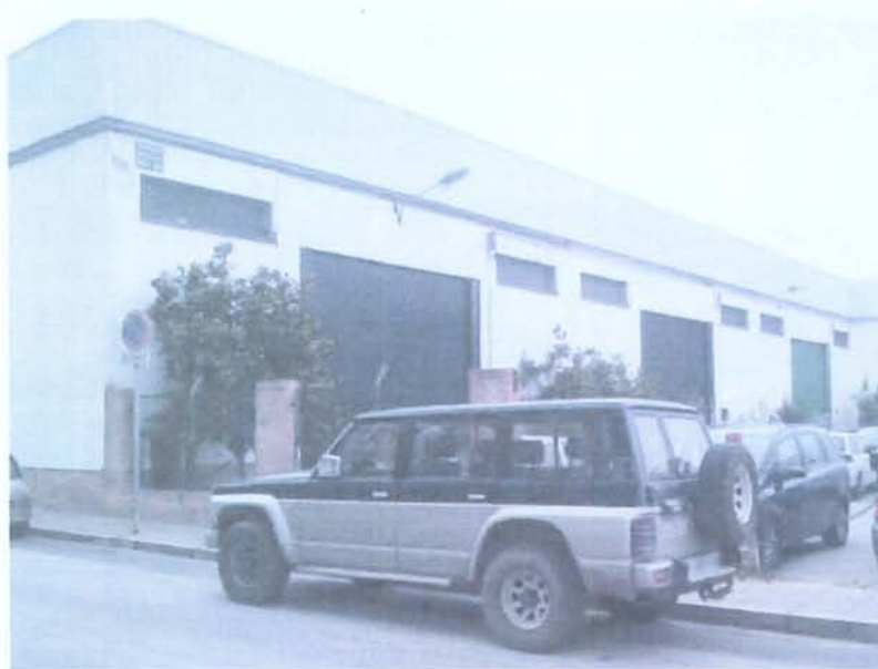
PATIO 2 FACHADA ESTE
