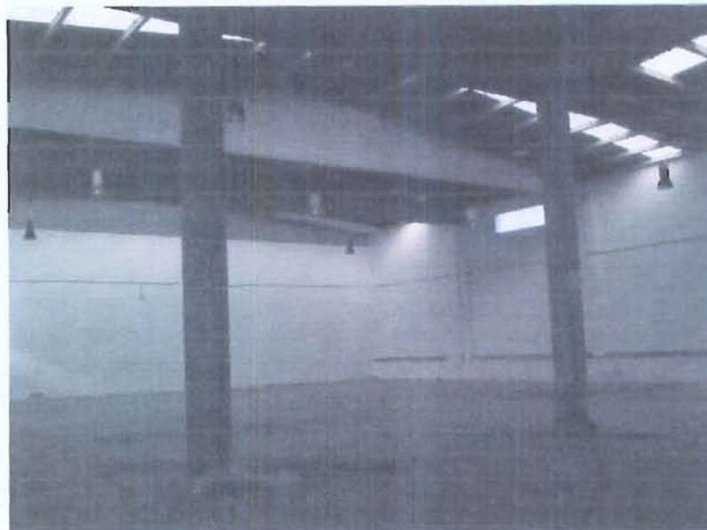
NAVE TIPO DE ELEMENTOS PREFABRICADOS DE HORMIGÓN
