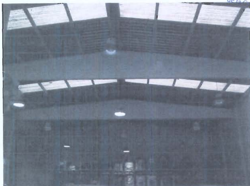
DETALLE CERCHAS HORMIGON PREFABRICADO
