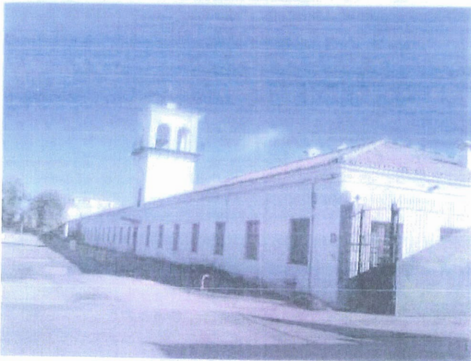
ACHADA A C/ SECOYA - EDIFICIO NORTE
