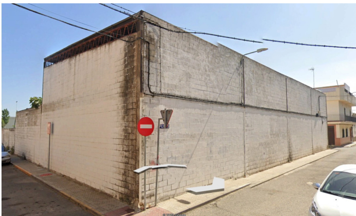
Nave fuera de ordenación y sin uso. Calle Peñas, Sacratif y Santa Pola
