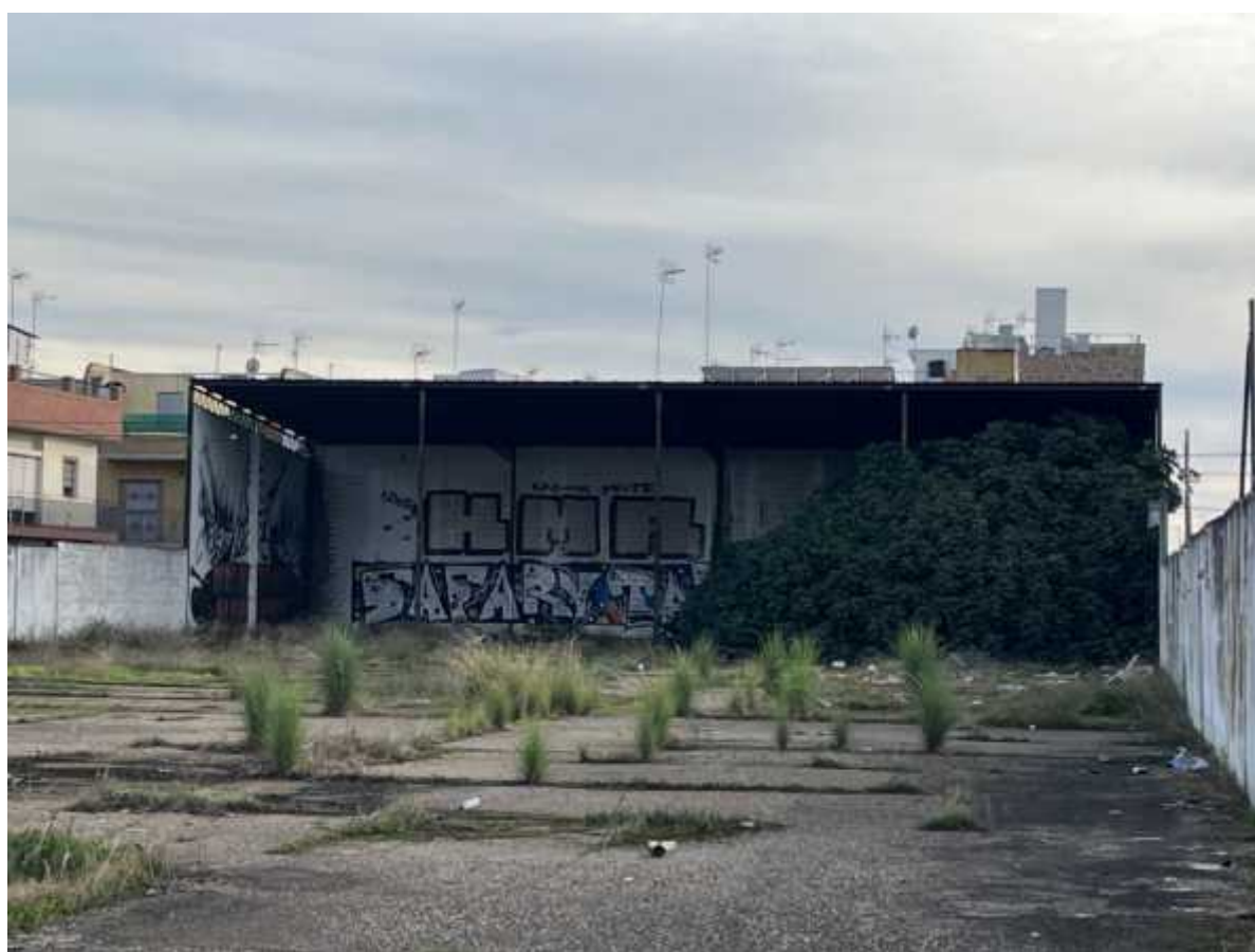
3º Nave 2: abierta, demoler uralita, citaras y solera. Valor calculado en Anexo 6.
