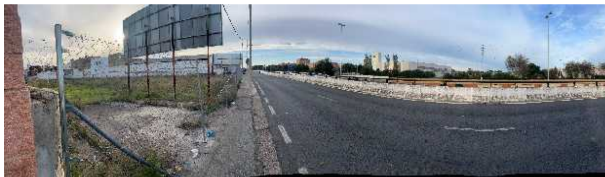
11º Sección doble calzada de la via de servicio de la A-92 sentido ascendente.
