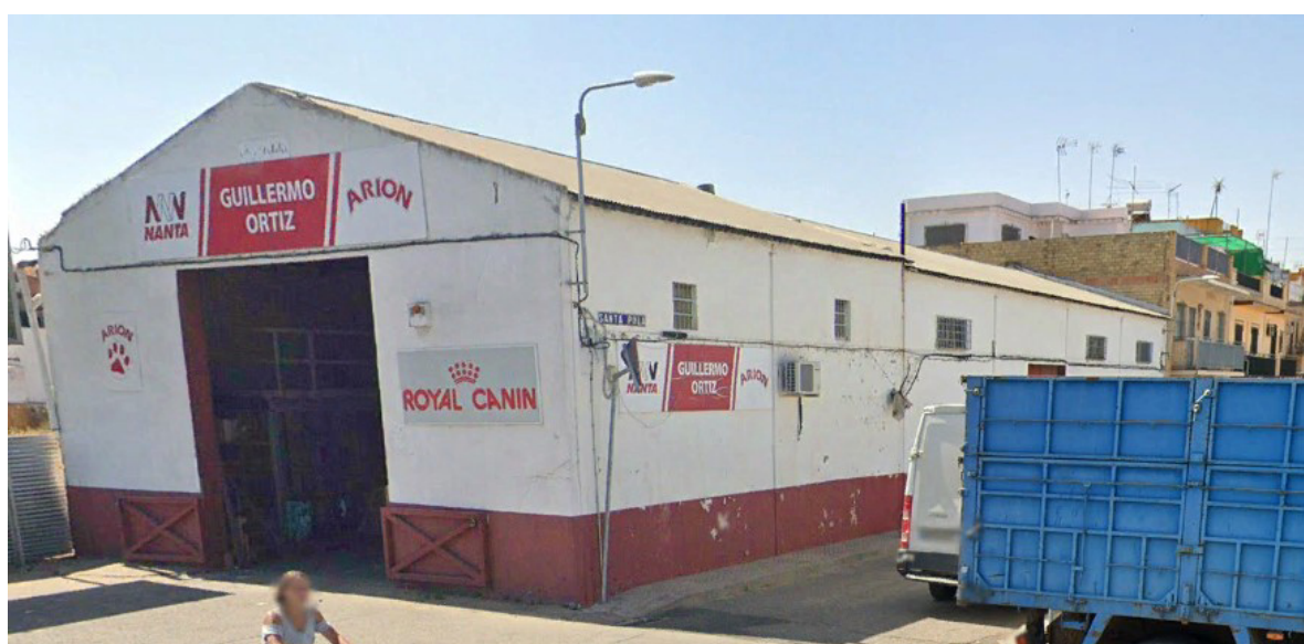
Nave en uso fuera de ordenación. Entrada vía de servicio A-92
