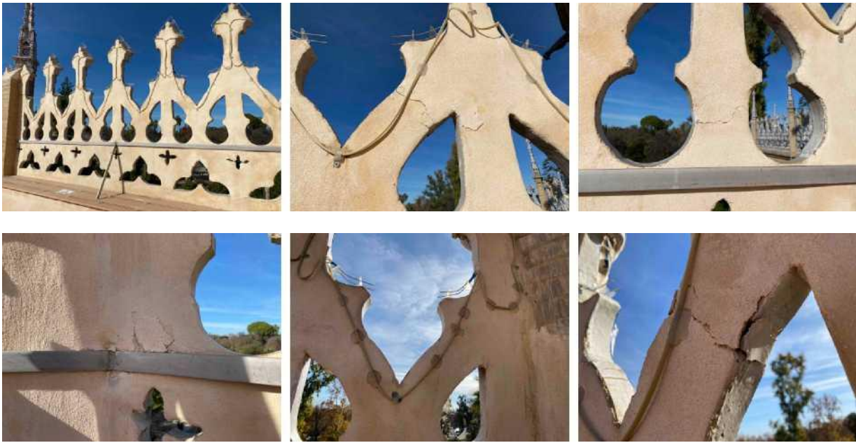
Grietas y fisuras en los morteros nuevos
