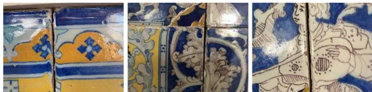
Intervenciones no documentadas, reintegración de volumen y color, Injertos cerámicos.
