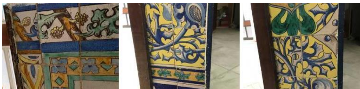
Intervenciones no documentadas, reintegración de volumen y color, Injertos cerámicos.
