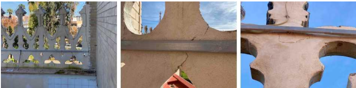
Grietas y fisuras en los morteros nuevos
