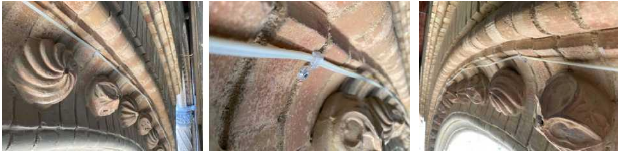
Instalación de cableado del sistema anti-aves sobre superficie de arcos a
