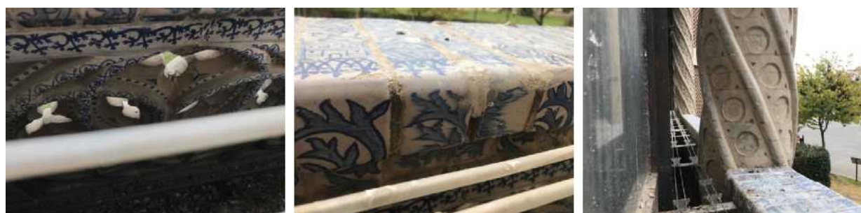
Repasos de morteros inacabados
