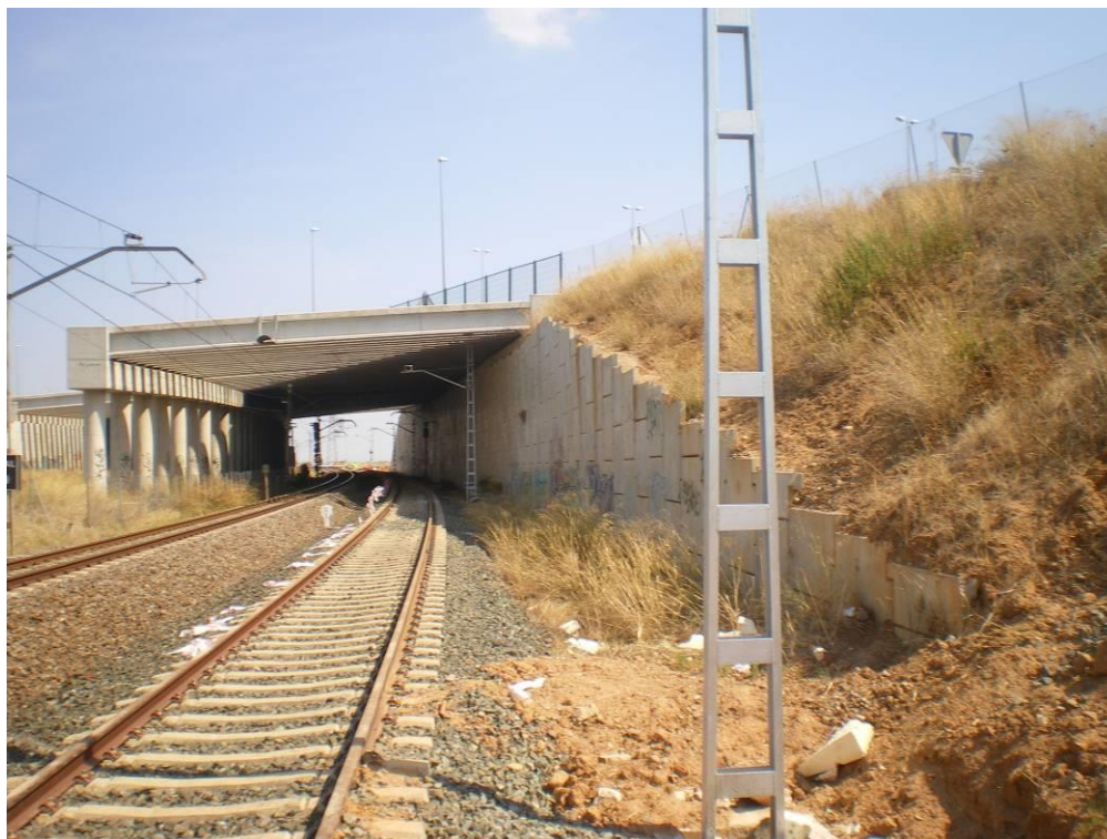
Vista del muro de tierra armada que contiene las tierras del terraplén de acceso a la pérgola.
